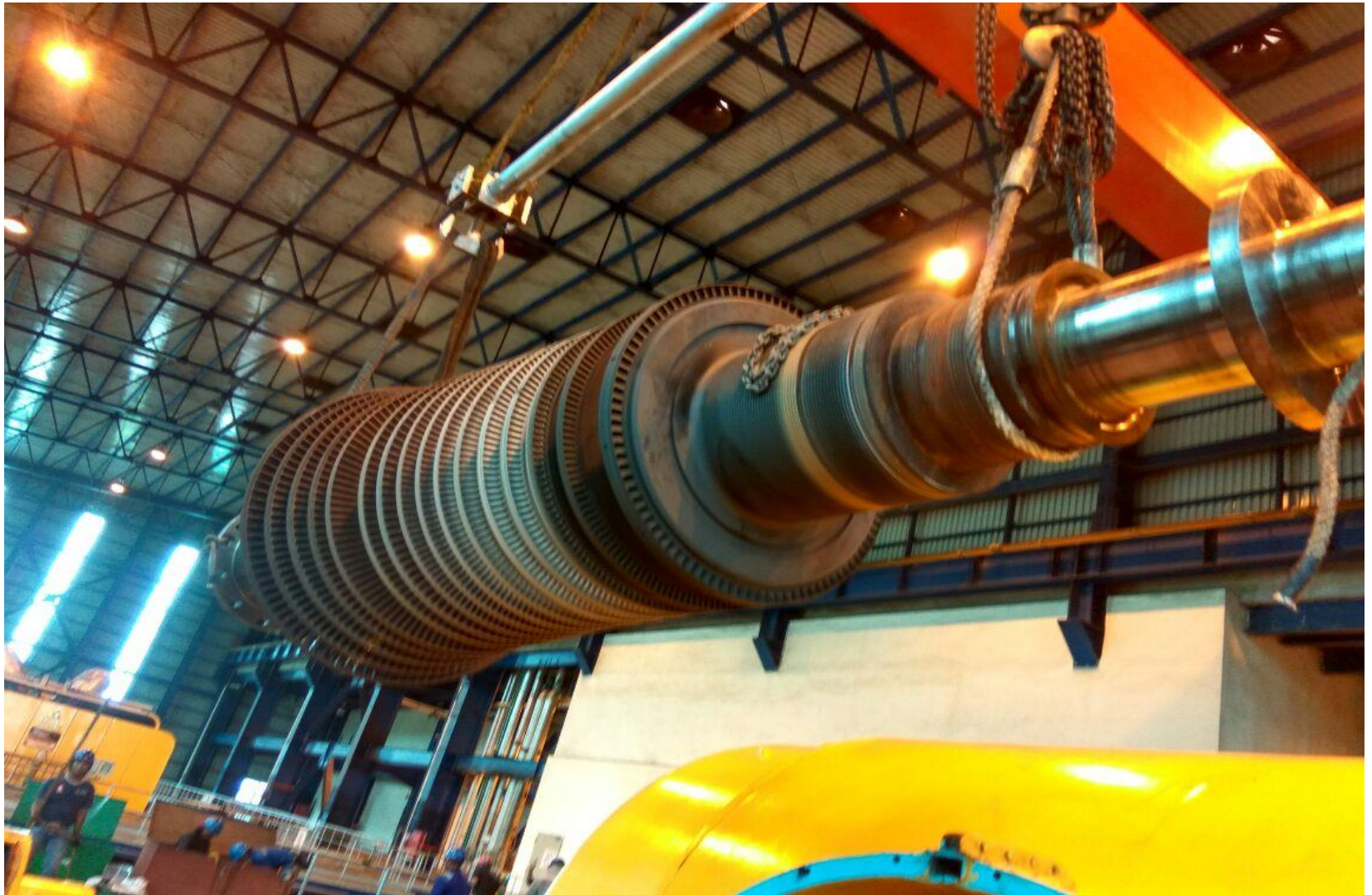
Lifting HP TURBINE ROTOR 110 MW AT PLN SEBALANG LAMPUNG
